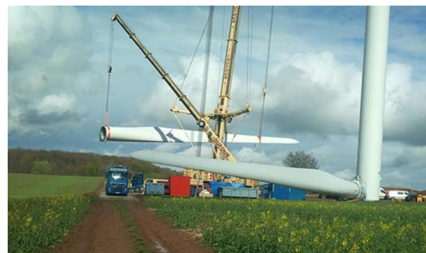
Figure 8 d'exemple de séquences d'assemblage d'une éolienne
