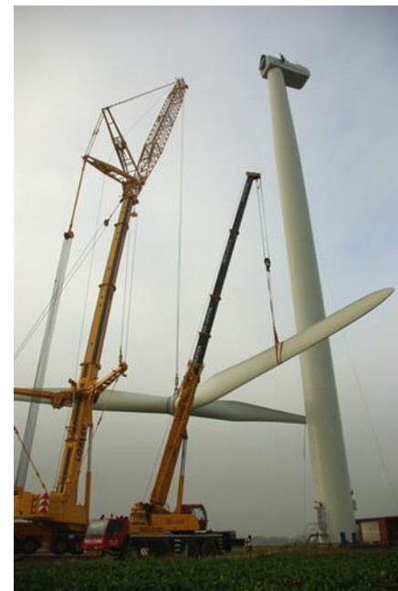
Figure 8 d'exemple de séquences d'assemblage d'une éolienne
